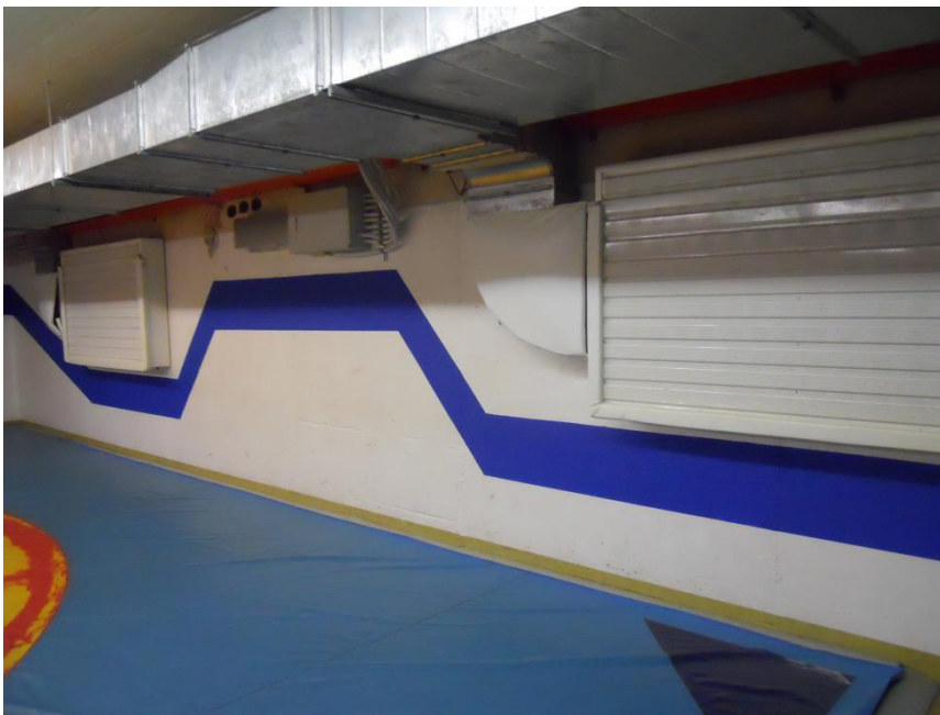
Abb. 18 Foto Ringkeller mit vorstehender Lüftung an der Wand (Unfallgefahr)
