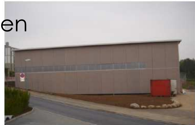
HOLZHALLE IN ZÜRICH-AFFOLTERN
