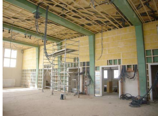
Dämmungen und Installationen Aula 2.OG
