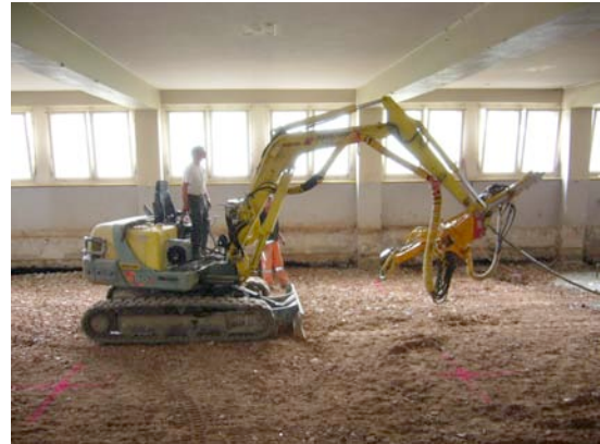
Pfählingen Bodenplatte UG
