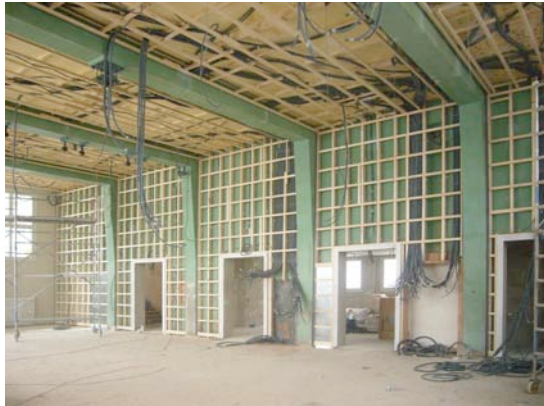
Lattungen und Installationen Aula 2.OG
